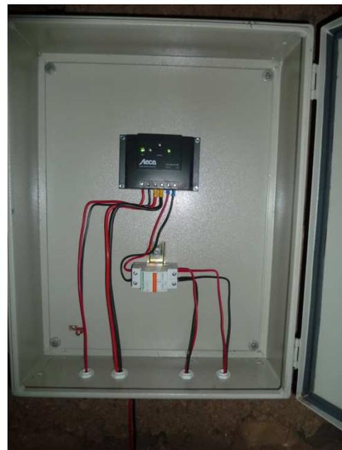
Ilustración 2.h: Regulador de marca Steca en Yerba Buena Alta, Cajamarca (16)
