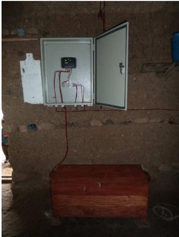
**Ilustración 3.h: Batería en caja de madera, unida al regulador, en Yerba Buena Alta, Cajamarca (16)**
