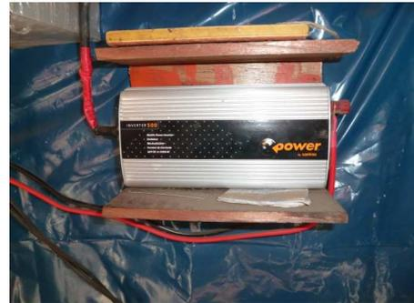
Ilustración 2.i: Inversor 12V CC/230V CA de marca Xantrex, potencia 500 W, en Alto Perú (5)
