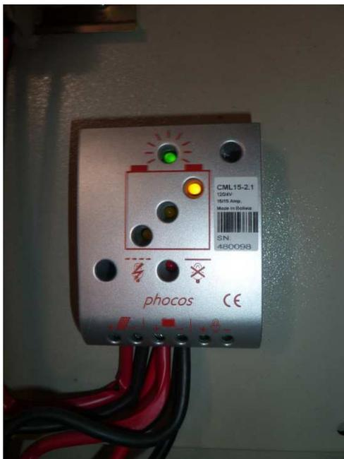
Ilustración 2.g: Regulador de marca Phocos en Alto Perú, Cajamarca (5)
