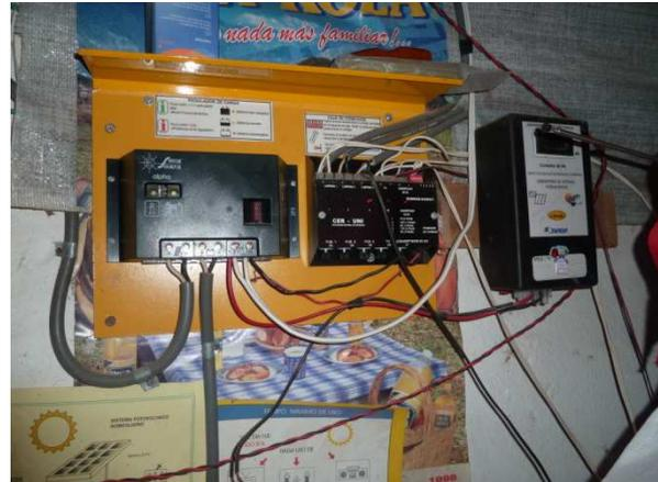
Ilustración 2.f: Regulador con caja de conexiones en el tablero de control, y contador de Ah, en Amantani, proyecto CER-UNI (12)
