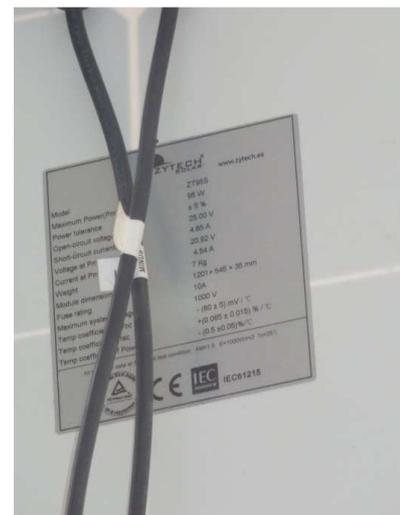
Ilustración 1.h: Etiqueta de características de un panel solar instalado en Alto Perú (5).  $P_M = 95 \text{ W}$ ,  $V_M = 20.92 \text{ V}$ ,  $I_M = 4.54 \text{ A}$ ,  $V_{OC} = 25 \text{ V}$ ,  $I_{SC} = 4.85 \text{ A}$
