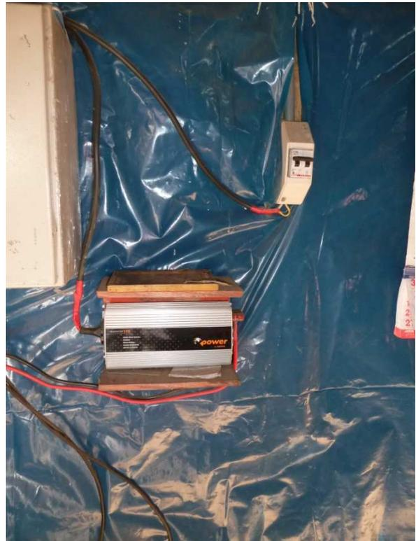
**Ilustración 3.i: Inversor sobre soporte de madera en Alto Perú, Cajamarca (5)**
