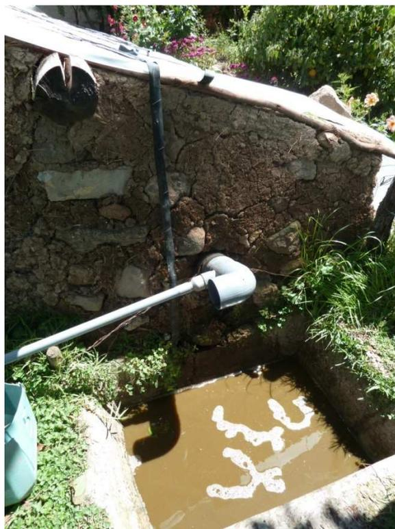
**Ilustración 1.ii: Caja de salida de biol (13)**
