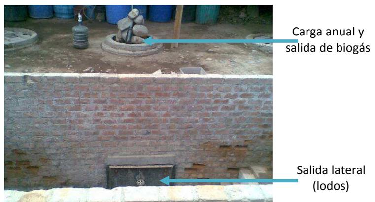
Ilustración 1.d: Salida lateral de lodos en la chacra ecológica de Pachacámac (Lima, Perú)
