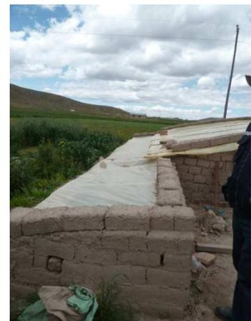
Ilustración 1.l: Biodigestor con tapiales e invernadero (9)
