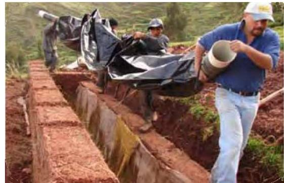
Ilustración 1.s: Colocación del reactor en la zanja (3)
