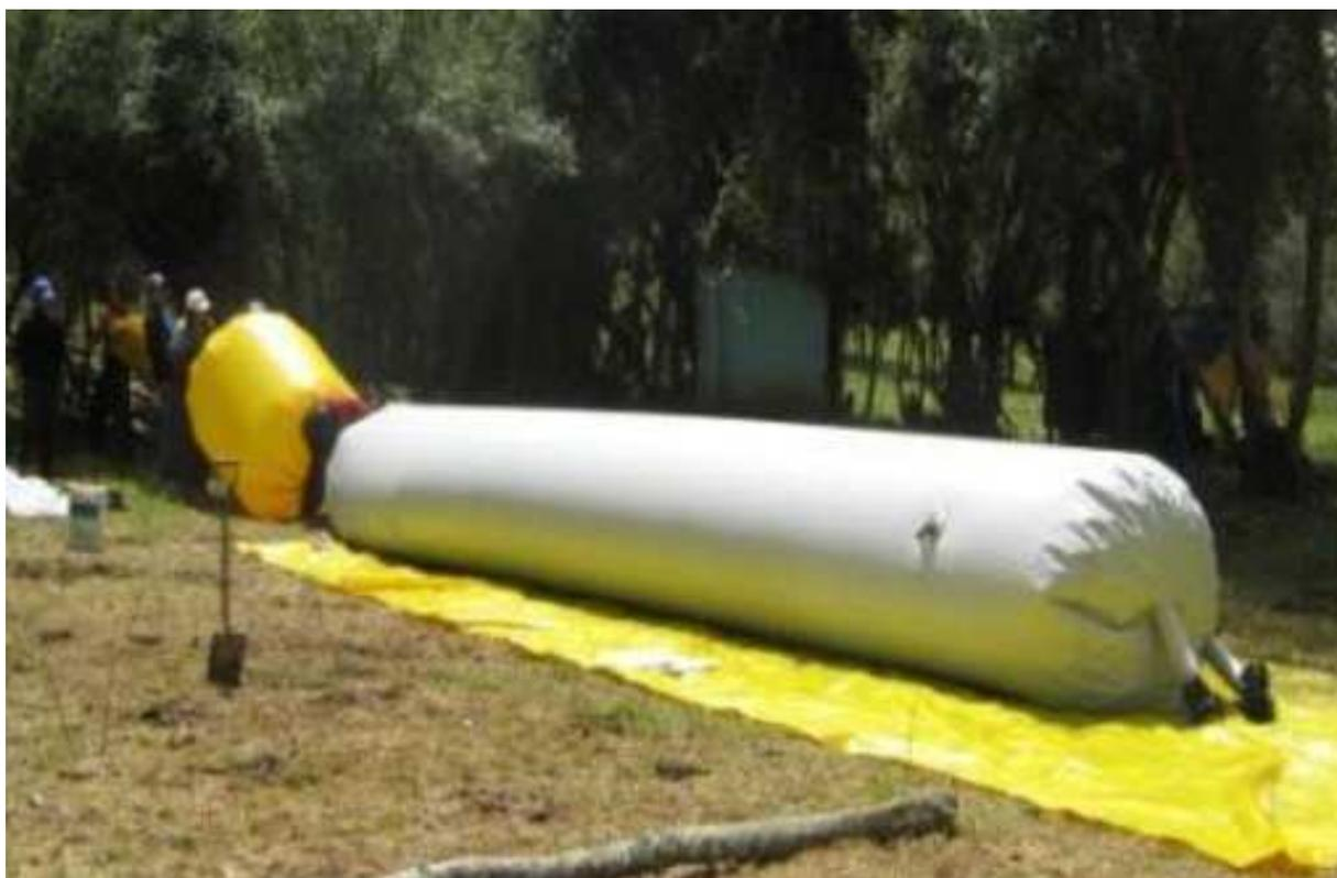
**Ilustración 1.u: Biodigestor de geomembrana de PVC listo para instalar (16)**
