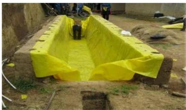
Ilustración 1.n: Zanja recubierta de una hoja de plástico (16)
