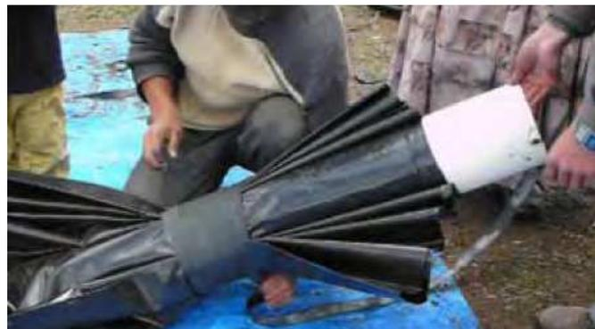
Ilustración 1.q: Pliegue del plástico para amarrarlo al tubo (3)
