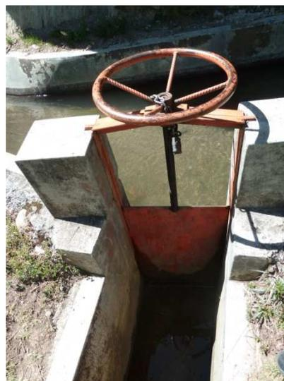
**Ilustración 2.z: Compuerta del desarenador, para sacar los sedimentos (11)**
