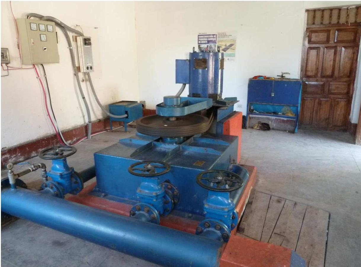
Ilustración 2.ww: Equipo electromecánico de la MCH de Yanacancha Baja: turbina en el primer plano, fajas y poleas, generador atrás, equipo de control en la pared izquierda (11)
