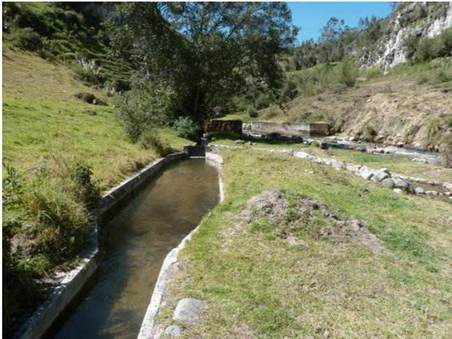
**Ilustración 2.u: Canal de concreto y primer desarenador (11)**
