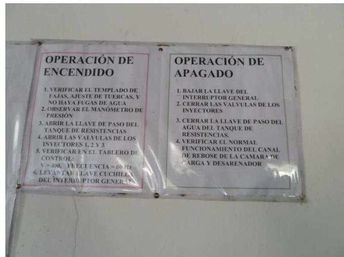
Ilustración 3.c: Lista de las operaciones de encendido y de apagado (11)
