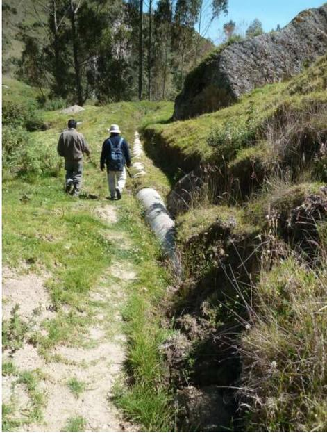
**Ilustración 2.w: Parte del canal hecho de tubería de plástico porque se había malogrado (11)**
