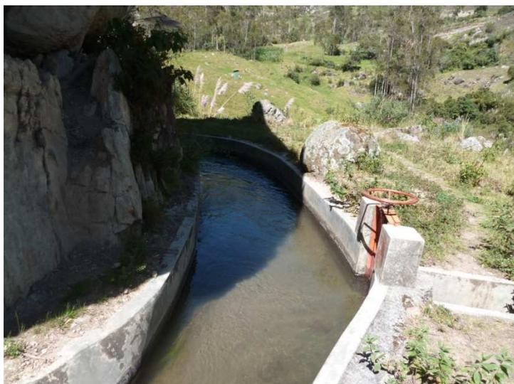
**Ilustración 2.y: Segundo desarenador, aprovechando una curva del río que reduce la velocidad del agua (11)**
