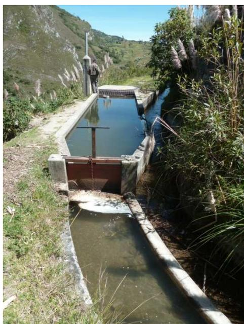
**Ilustración 2.aa: Tercero y último desarenador, antes de la cámara de carga (11)**
