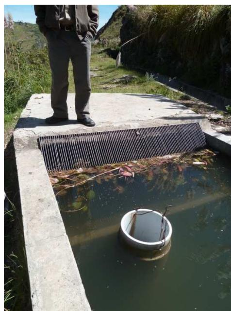
**Ilustración 2.bb: Cámara de carga con reja en la entrada y sección amovible del tubo de desagüe de limpieza (11) (8)**
