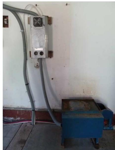
Ilustración 2.tt: Mecanismo de evacuación del excedente de electricidad en forma de calor en una resistencia sumergida (11)
