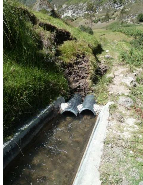
**Ilustración 2.x: La tubería echa el agua a otra parte del canal de concreto en buen estado (11)**
