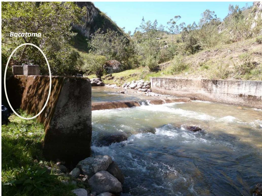
Ilustración 2.s: Pequeño rebalse antes de la bocatoma, bocatoma, caudal restante en el río (11)
