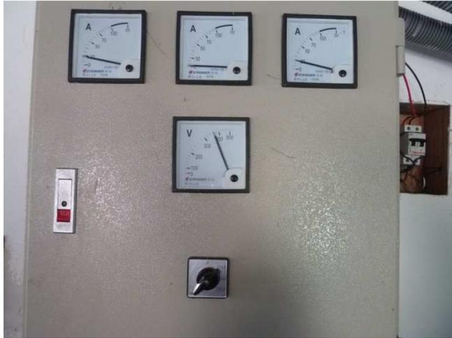
Ilustración 2.qq: Tablero de control con mediciones de intensidades (corriente trifásica) y tensión (11)
