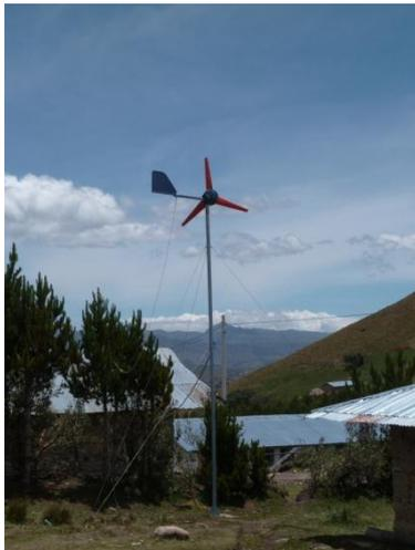
**Ilustración 3.a: IT-PE-100 con un tubo galvanizado como torre soporte (8)**
