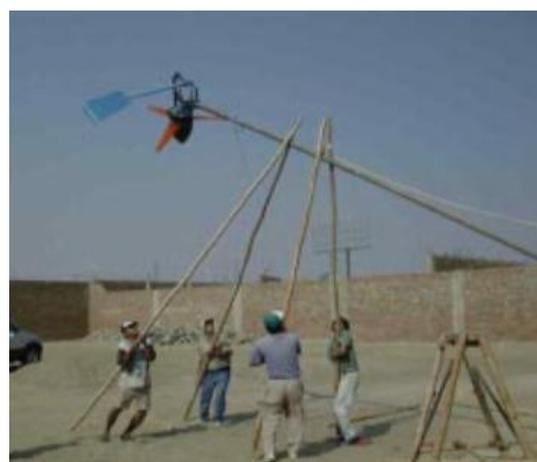
Ilustración 3.f: Izamiento de un IT-PE-100 en el Perú mediante postes y cuerdas (9)
