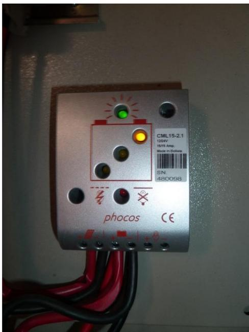
Ilustración 2.q: Regulador de marca Phocos en Alto Perú, Cajamarca (16)
