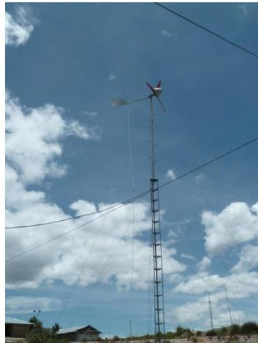
**Ilustración 3.b: IT-PE-100 en mayor altura, con una torre más robusta (8)**
