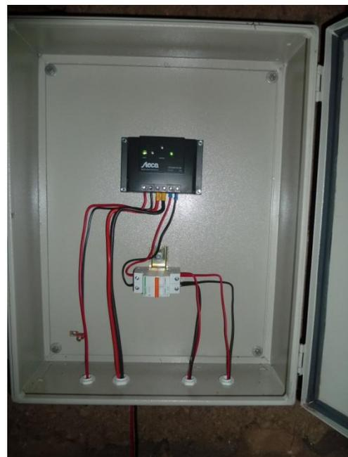
Ilustración 2.r: Regulador de marca Steca en Yerba Buena Alta, Cajamarca (17)
