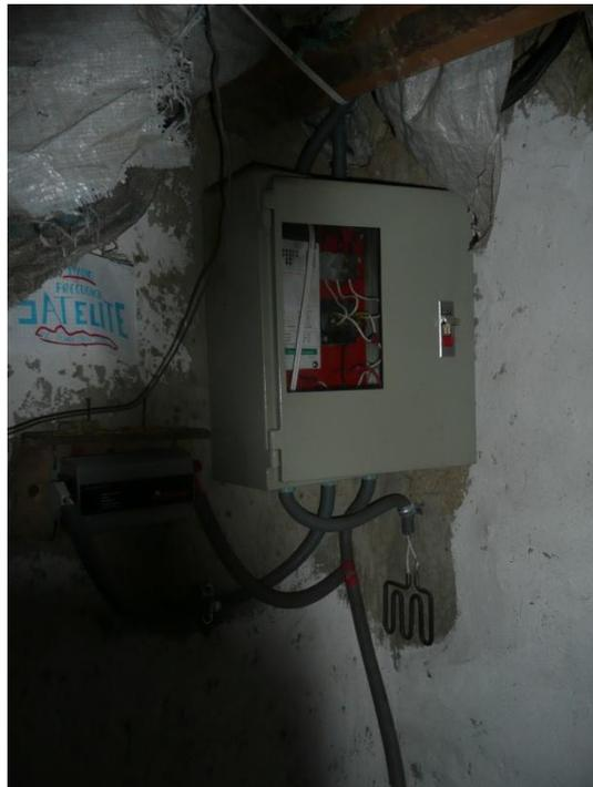
**Ilustración 2.n: Tablero de control conllevando el regulador y tablero de control, y resistencia de disipación debajo, en El Alumbre (8)**
