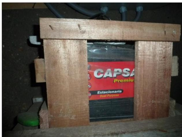
Ilustración 2.u: Batería estacionar CAPSA en El Alumbre, Cajamarca (8)
