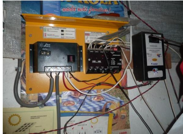
Ilustración 2.p: Regulador con caja de conexiones en el tablero de control, y contador de Ah, en Amantani, proyecto CER-UNI (15)
